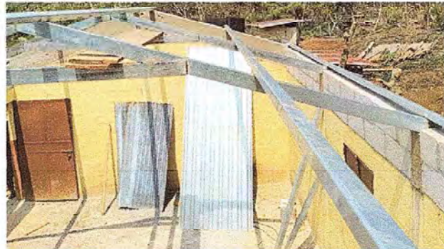
Foto 2: Instalando estructuras de techo. Costaneras y laminas troqueladas en Modulo I.
