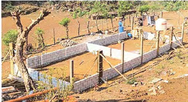
Foto 4: Se levanta 4 hiladas de block en modulo II.
