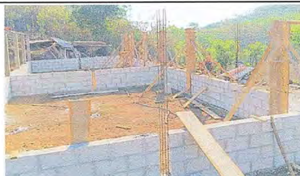
Foto 6: Fundición de comunas en Modulo II.
