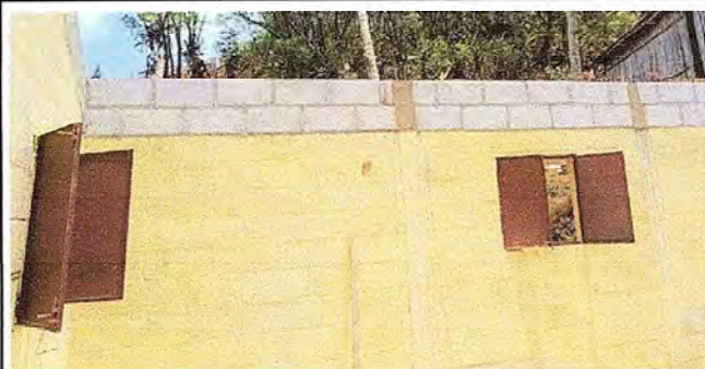
Foto1: Levantamiento de dos hiladas de block en Modulo I.
