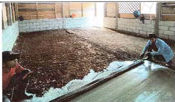
Foto 5: Instalando piso de concreto en aulas del Modulo II.
